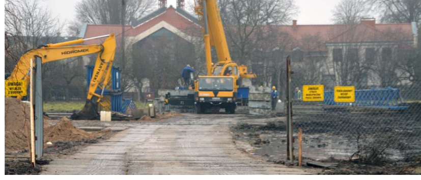
Początek budowy osiedla mieszkaniowego w centrum miasta
