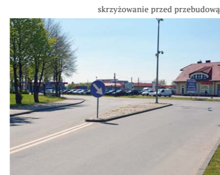
skrzyżowanie przed przebudową
