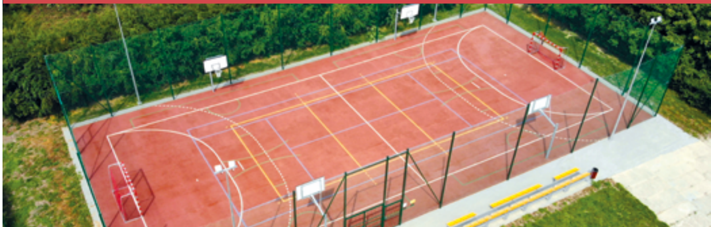
Budowa boiska w Kmiecinie
