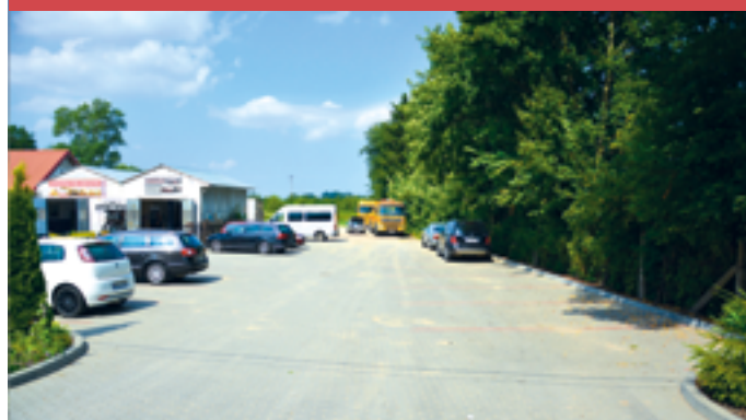
Budowa parkingu w Orłowie
