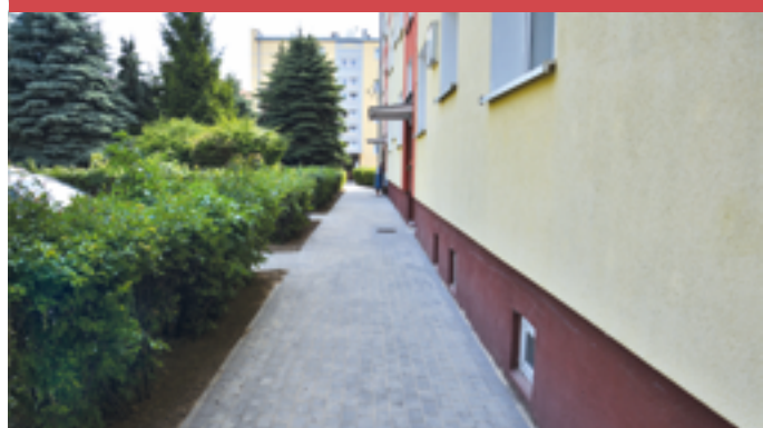
Przebudowa chodnika przy Reja 2
