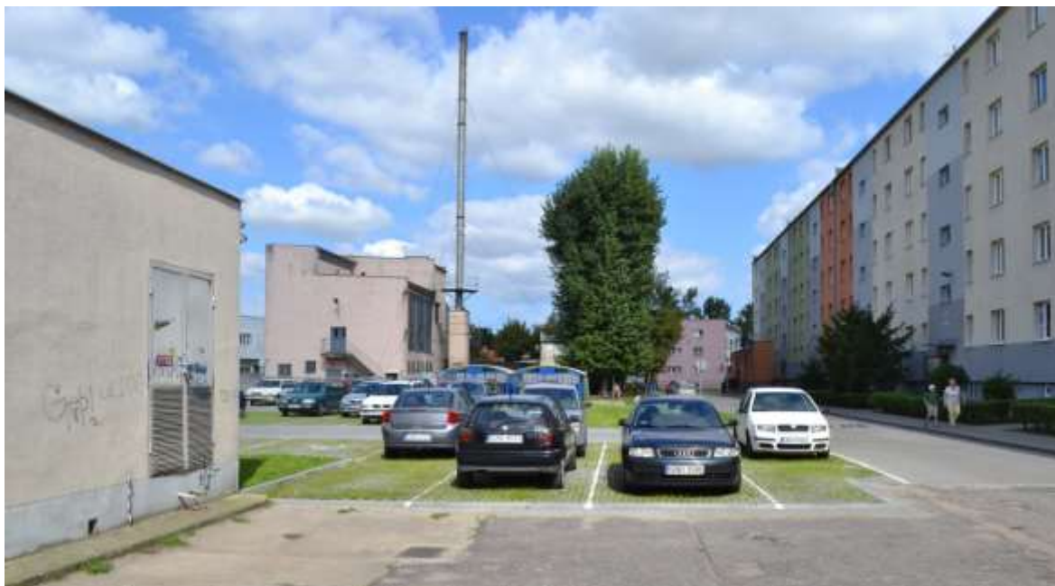
Rysunek 22 Widok na ciepłownię od strony południowej
