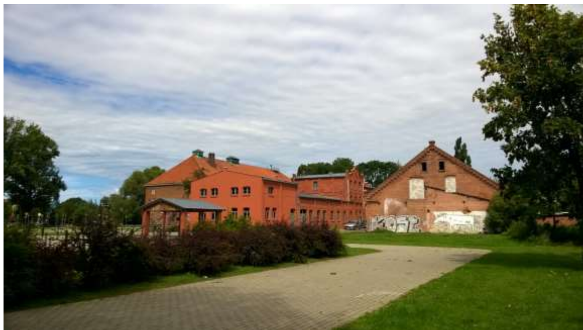
Rysunek 9 Widok na przestrzeń publiczną za budynkiem Żuławskiego Parku Historycznego od strony rzeki
